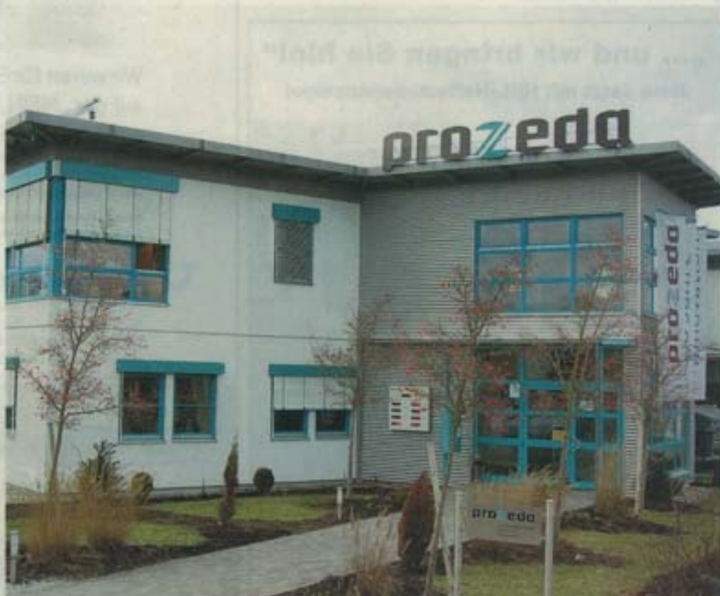
In nur vier Monaten entstand die 1100 Quadratmeter große Halle.
